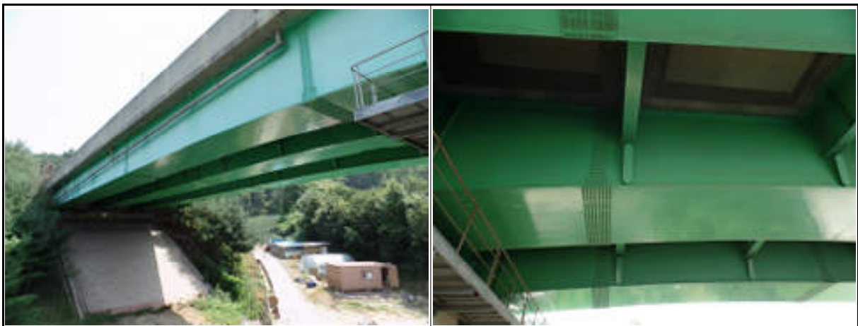
Steel Box Girder 외부 전경
